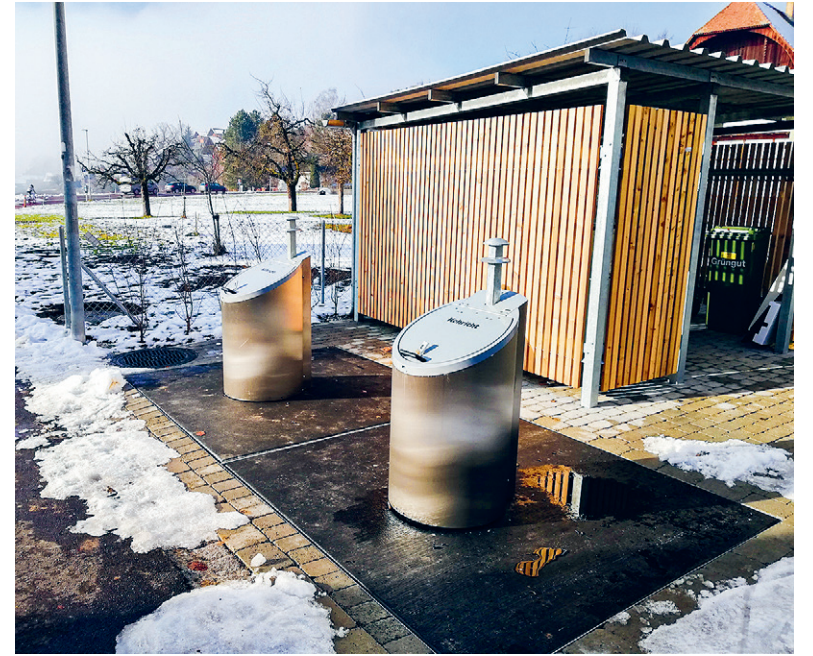
Der neue Unterflurcontainer an der Scheidgasse kann ab sofort benutzt werden.
