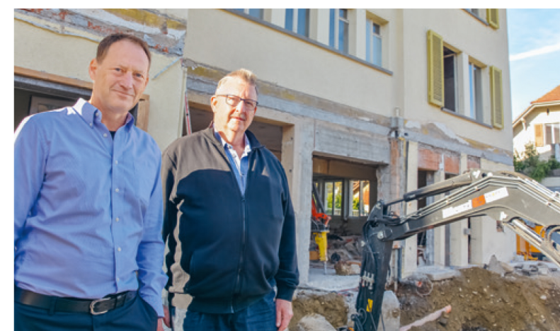
Die Baumaschinen sind aufgefahren. Von den einstigen Bankräumlichkeiten am Höchhusweg ist nicht mehr viel zu sehen. Martin Bruppacher, Vorsitzender der Geschäftsleitung der Raiffeisenbank Steffisburg (l.) und Verwaltungsratspräsidenten Hans-Rudolf Zaugg, sind mit dem Baustart zufrieden.
