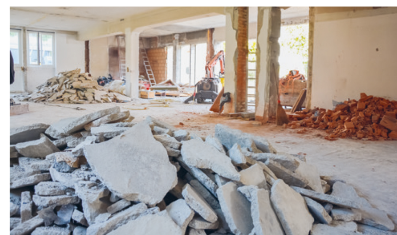
Baustelle statt Bankgeschäfte: Die Innenräume werden ausgehöhlt.
